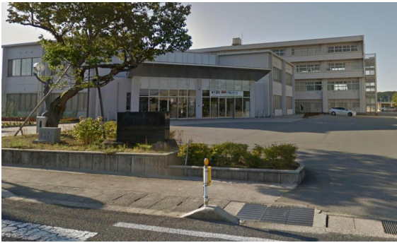
玄関の奥に1階スペース
