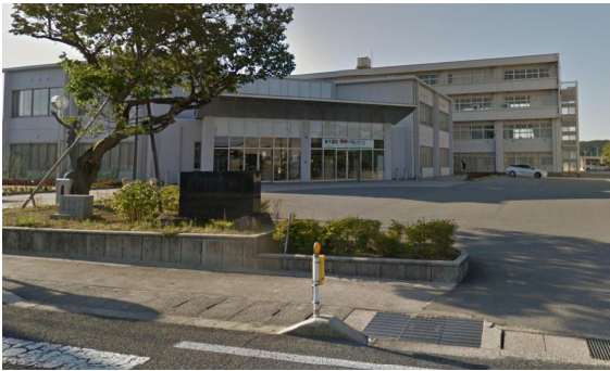
玄関の奥に1階スペース
