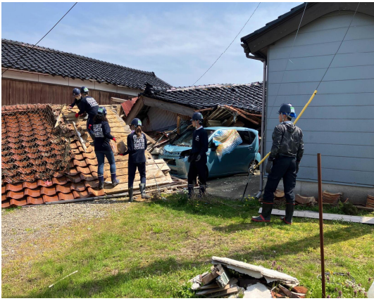
1階の瓦をはがす
