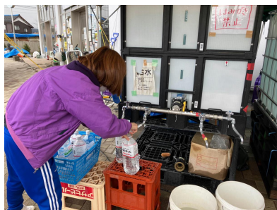
玄関横の給水所 断水中
