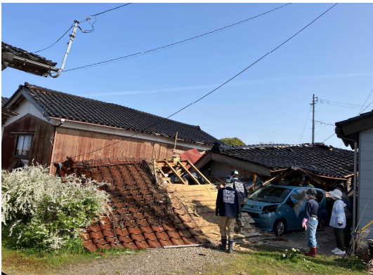
屋根の下地を壊す
